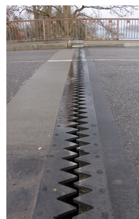
Slika 2.6: Mostovi se sastoje od ploča koje su malo razmaknute jedna od druge. Na tim razmacima se nalaze „češljevi“, koji služe da taj razmak bude na svim temperaturama pokriven na kolovozu.
